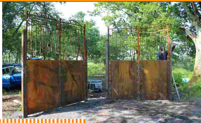
Installation du portail sur le site du Saucissé
