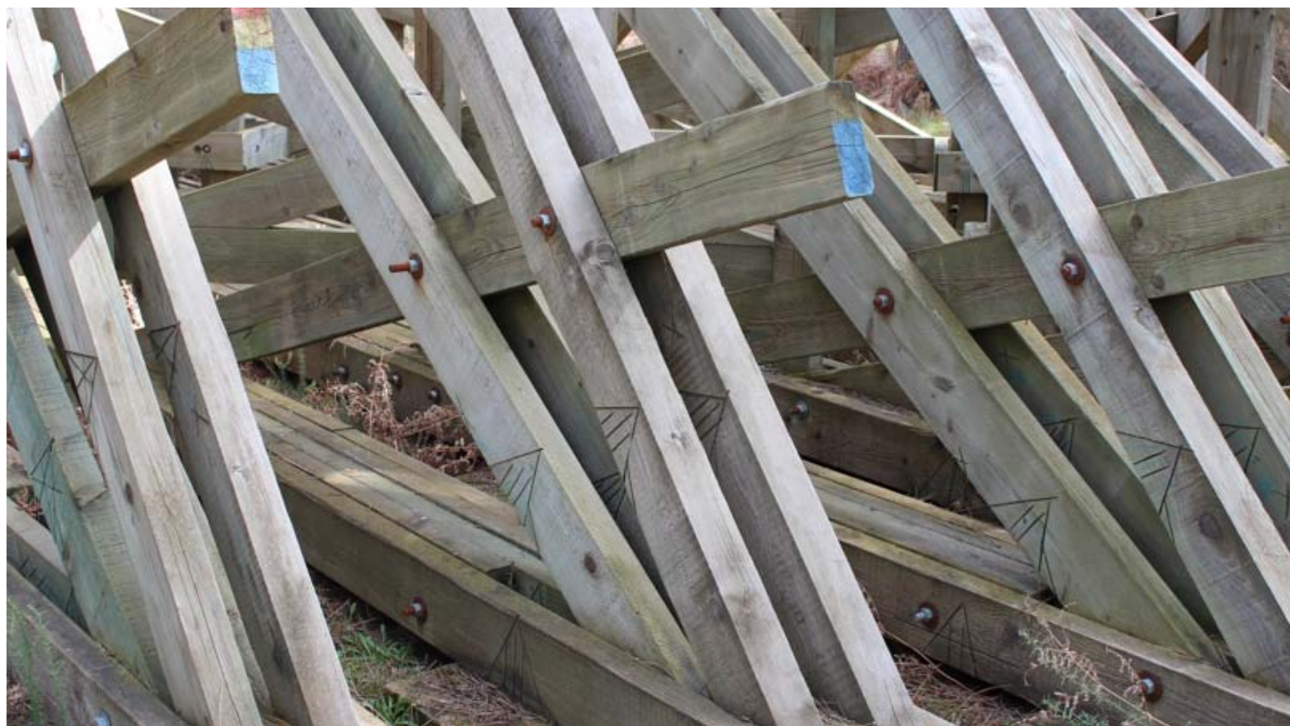
détails de l'œuvre, signes de charpentier
